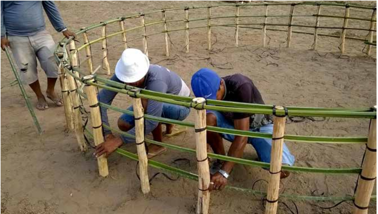
Construção do tanque circular de papelão - amarração das varas nos estacotes.
