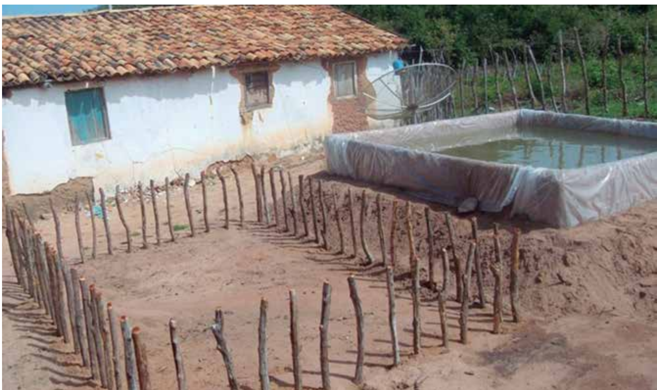
Armação de madeira do novo tanque e tanque de papelão e plástico.
