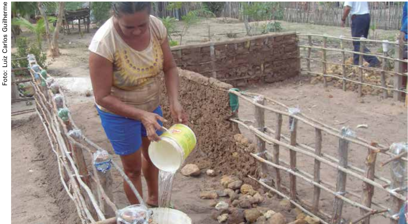
Construção do tanque retangular de taipa.
